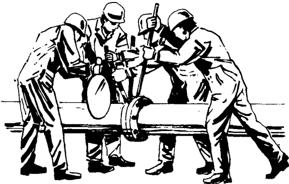
Fig. 1 Instalación de una placa maciza entre bridas
