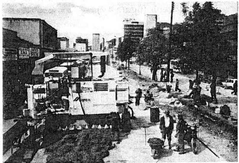
Figura 4.7 Dispositivos de repartición del concreto delante de la máquina de formaleta deslizante.
